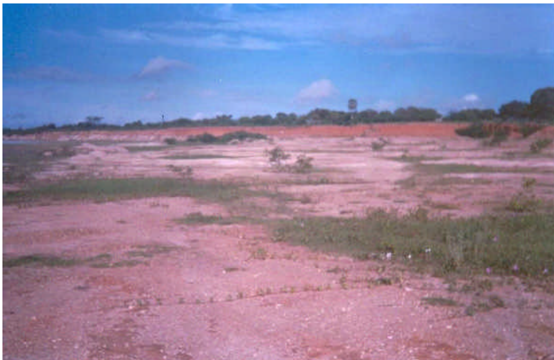
Foto 1.2.3.5 – Terreno dissecado mecanicamente para retirada de material para o maciço compactado do Açude Curral velho. Na parte superior da foto vê-se a barreira de sedimentos conglomeráticos da Formação Faceira.
