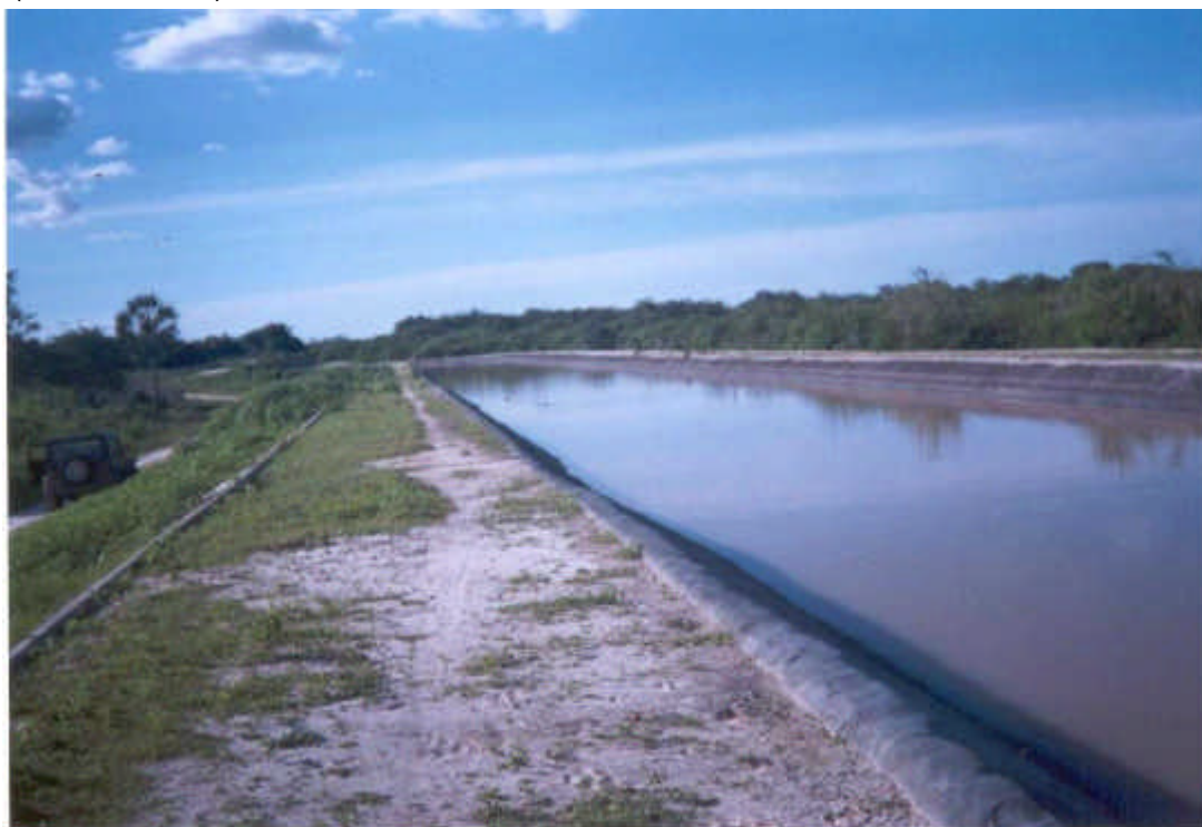
Foto 1.2.3.13 – Canal do Trabalhador; trecho executado em aterro com manta asfáltica.
