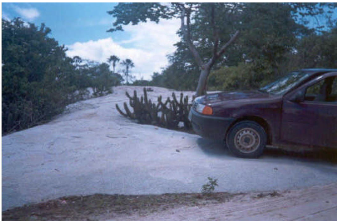
Foto 1.2.3.7 – Afloramento de rocha com estrutura granítica próximo ao eixo.
