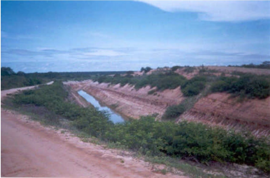
Foto 1.2.3.14 – Canal do Trabalhador, escavado em solo até aproximadamente 8m de profundidade, e a partir daí em rocha, até o fundo do canal.
