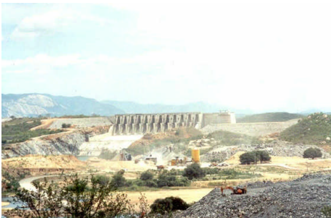
Foto 1.2.3.1 – Vista de jusante da Barragem do Castanhão em obras.
